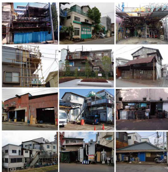
図7 多様な町工場の建造物
